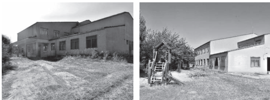
Edificio de la escuela en Mahíde (CRA) (2018).
