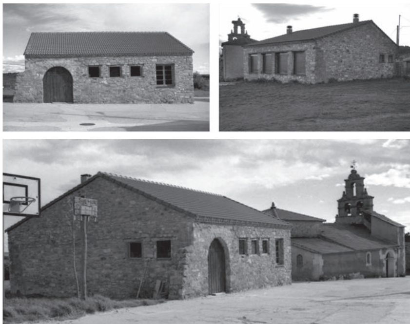
2002. Situación final una vez terminada la recuperación del edificio.
