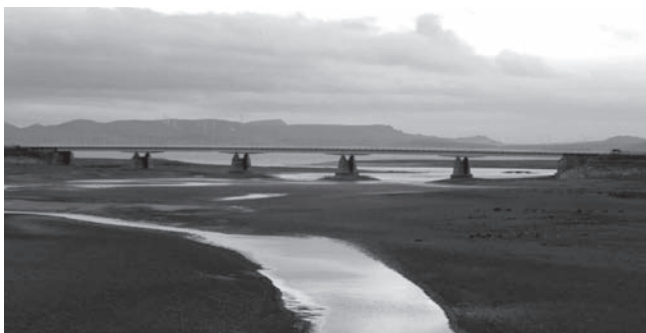
Puente actual que conecta un barrio con otro en La Población. Antiguamente en el mismo sitio que ocupa este puente nuevo, existía un pequeño de piedra, por el que se podía cruzar si las aguas estaban bajas. Si estaban altas, quedaba anegado.
