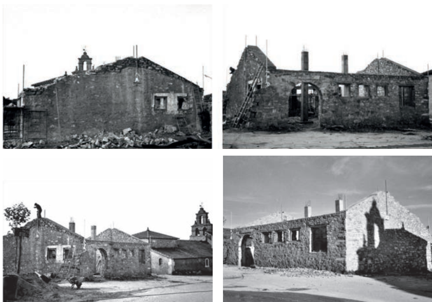
2000-2001. Proceso de reconstrucción.
